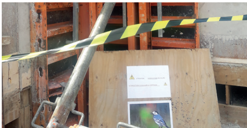
Nid de Bergeronnette grise ( Motacilla alba alba ) préservé sur le chantier de la ligne 17 du Grand Paris Express.
