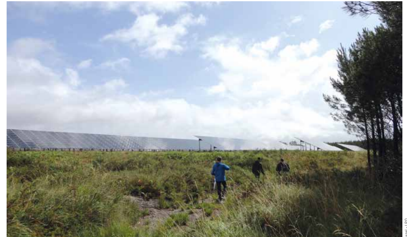
Centrale solaire de Montendre (en Charente-Maritime).
