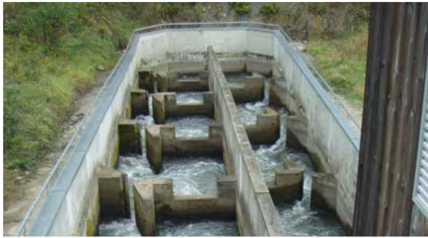
Passé à bassins successifs, centrale de Susmiou, gave d'Oloron.
