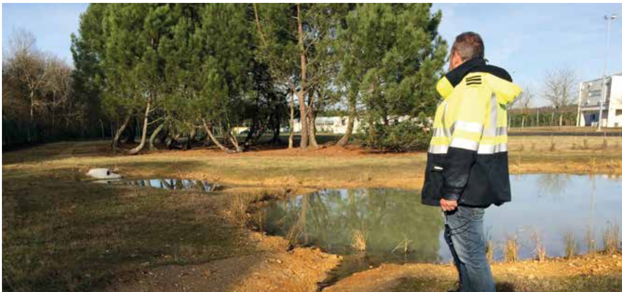
Exemple de mesure en faveur de la biodiversité prise sur le site de stockage souterrain de gaz naturel de Céré-la-Ronde (Indre-et-Loire) : l'aménagement de mares alimentées par un système de récupération des eaux pluviales.
