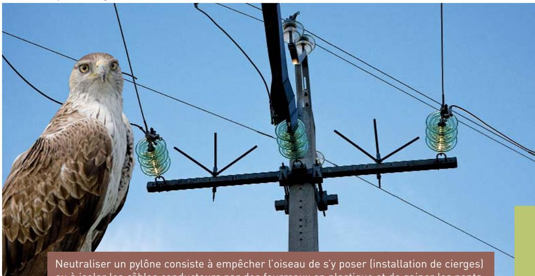
Neutraliser un pylône consiste à empêcher l'oiseau de s'y poser (installation de cierges) ou à isoler les câbles conducteurs par des fourreaux en plastique et de gainer les ponts conducteurs. Un perchoir de substitution peut également être installé sur certains armements pour empêcher l'oiseau d'accéder aux parties sous tension du pylône.
